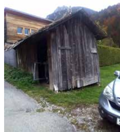
Démolition d'un grenier
