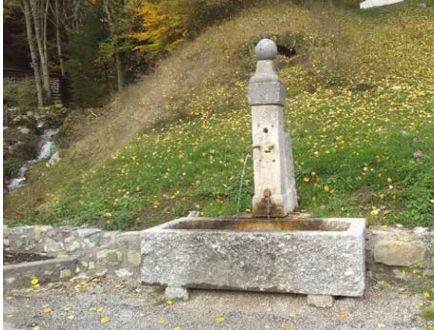
Bassin du Bas Thex après travaux
