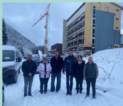
Démolition de la MGEN
