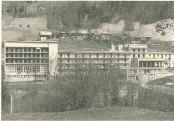
Le sanatorium «Sylvabelle» après les premières tranches de travaux réalisés par la M.G.E.N. et tel qu'il fonctionnera jusqu'en 1976.
