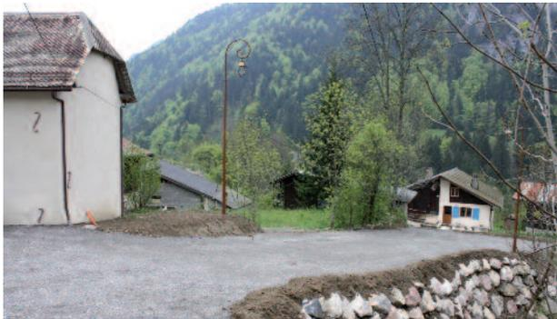
La création des places de parking a nécessité la construction d'un enrochement pour soutenir la plateforme.
