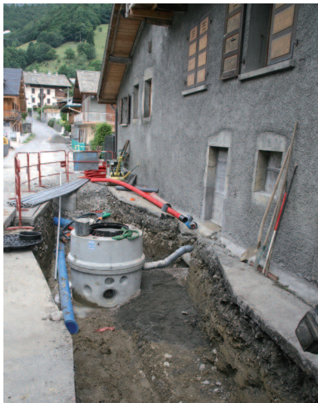
Les travaux d'eau et d'assainissement sur la tranche de chez Clément Coffy au Plein Soleil
