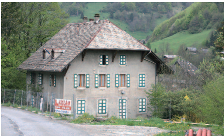
La maison des Sœurs a disparu du paysage de la commune avec la démolition du bâtiment l'hiver dernier.
